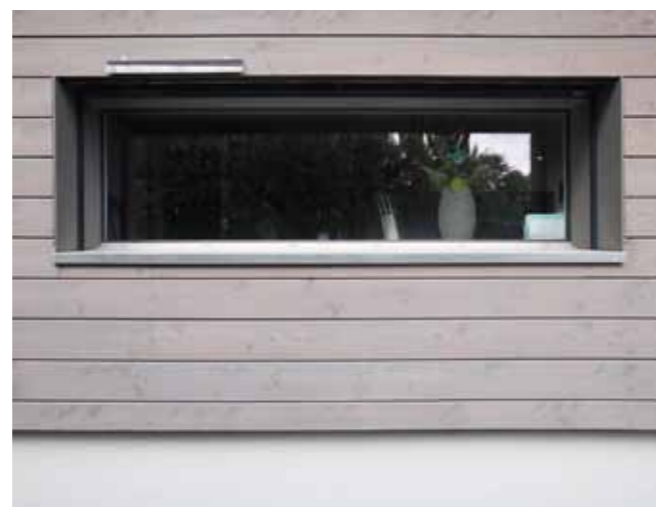
Un système de mini capteur solaire assure le fonctionnement du moteur d'un store équipant la fenêtre horizontale de la cuisine. Ingénieux et pas courant.
