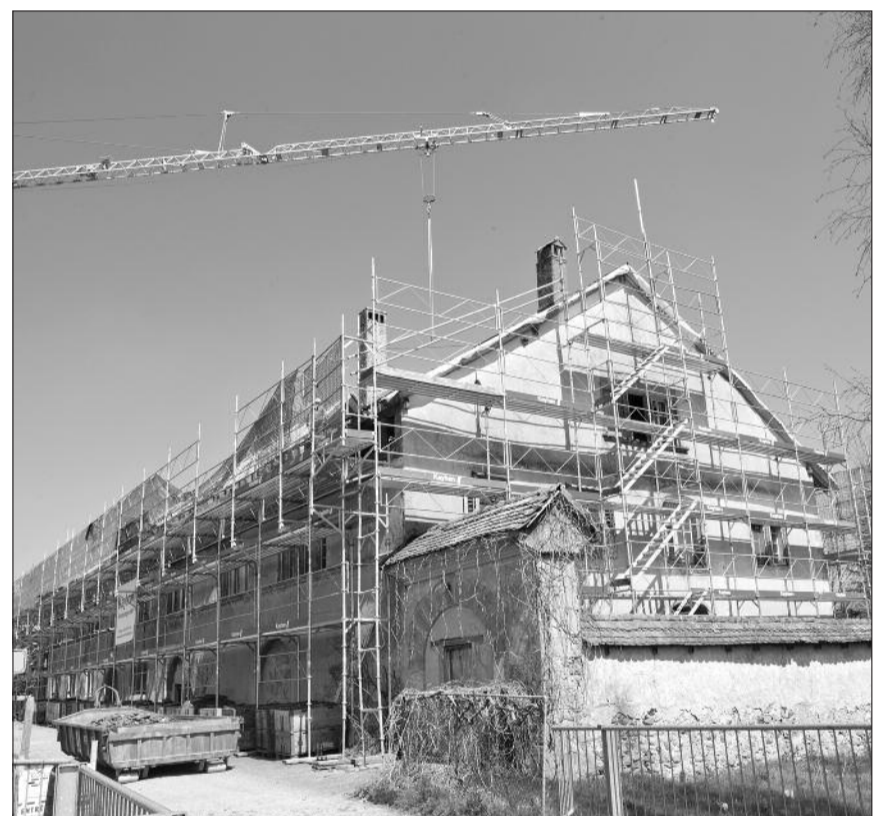
Le bâtiment de l'hôtellerie, qui accueille visiteurs et retraitants, subit actuellement une mue. Sa charpente retrouvera bientôt son apparence d'avant 1908, plus élancée. En effet, les rénovations du début du XX e siècle avaient aplati et affaibli la structure. PHOTOS CHLOÉ LAMBERT
