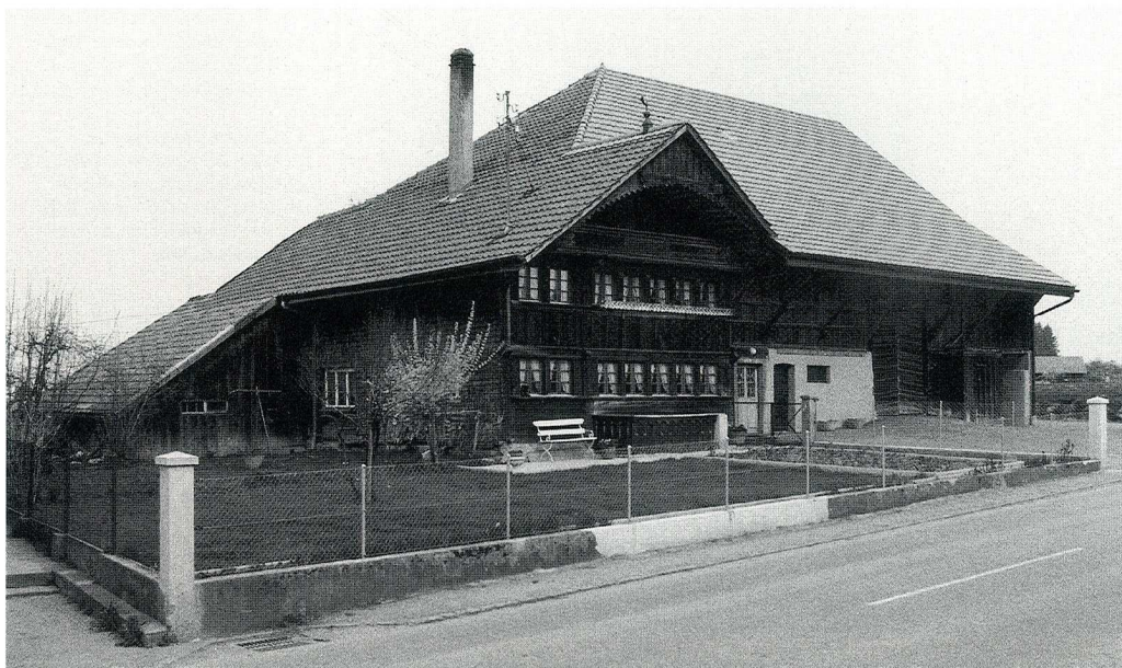
Fig. 3 La maison Monney de Sâles en 1990, état avant transformation. La petite annexe appuyée à la façade latérale du logis a été supprimée, alors que la cheminée trop haute a été remplacée par une plus petite, de type traditionnel.
